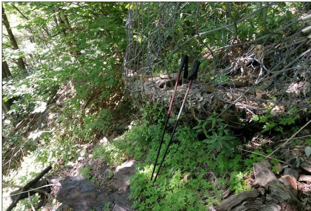
Foto 15: Particolare del detrito di piccola pezzatura fermato dalla barriera sottostante il settore 6.
