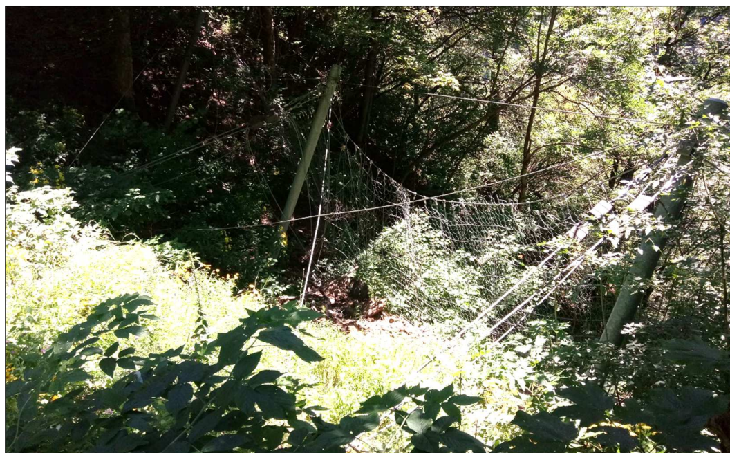
Foto 14: Vista sulla barriera paramassi installata a valle del settore 6, si notano alcuni blocchi di pochi decimetri cubi di volume fermati dalla rete.
